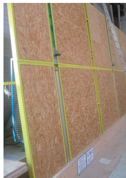
Une fosse permet de descendre le panneau d'ossature bois et de poser le bardage à hauteur d'homme.
