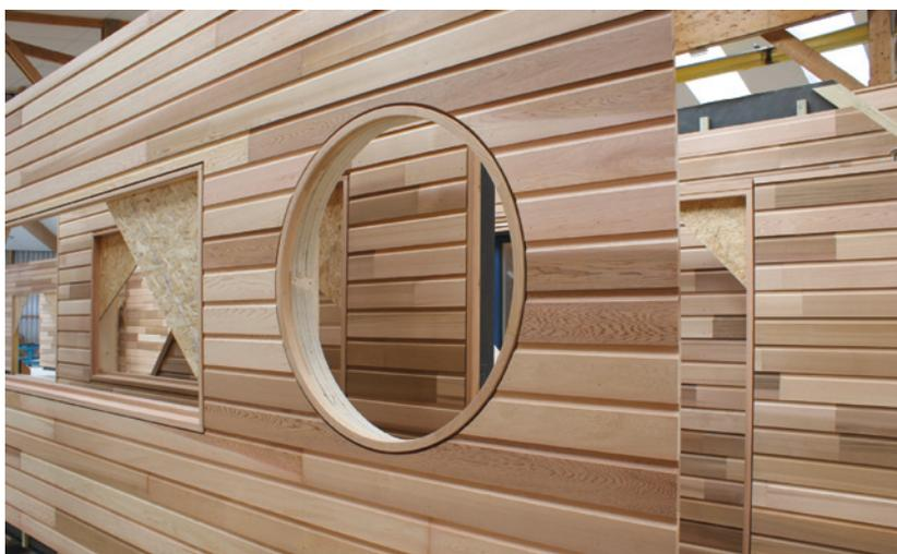
Les murs fabriqués par GLV sont à 75% revêtus de bardage en red cedar et sortent tous d'atelier avec leurs précadres de menuiseries. Afin de préserver la géométrie de ces précadres pendant le transport et le montage, des renforts provisoires sont fixés aux angles comme ci-contre. L'isolation et le pare-vapeur sont mis en oeuvre sur le chantier.
